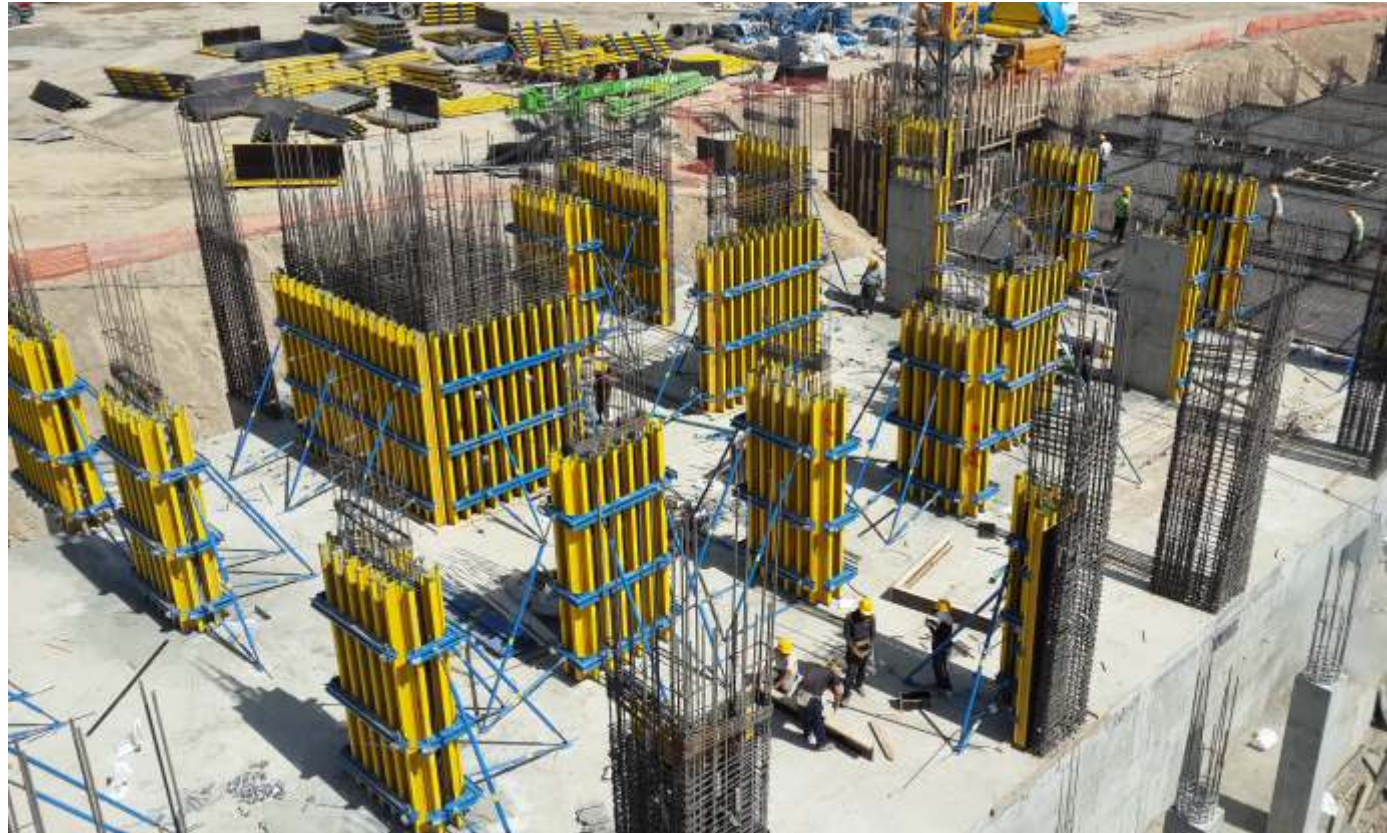
Çekirdek perde kalıplarının kolay bir şekilde sökebilmek için paneller arasına adaptör montajlanır. Beam clamp is placed between panels to enable removing of wall formworks inside core wall.
